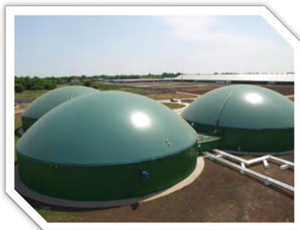
*Построенный ферментатор с изолированными стенами.*
