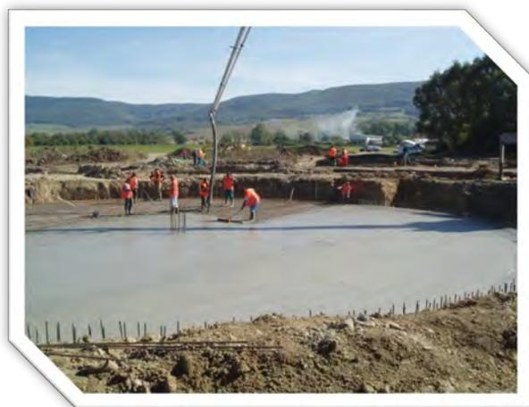
*Заливка плиты дна ферментатора.*
