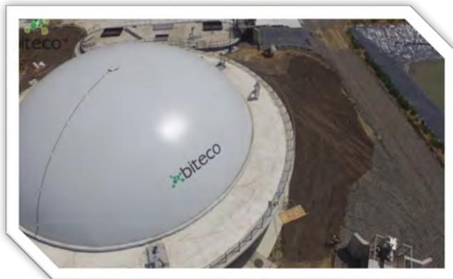
*Газгольдер смонтированный на ферментаторе.*
